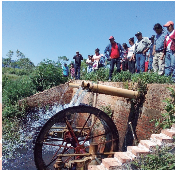
Imagen 3: Inspección A la presa de cemento sobre el río, en la propiedad "San Lorenzo". Fotos: TCO Turubó-Este.
